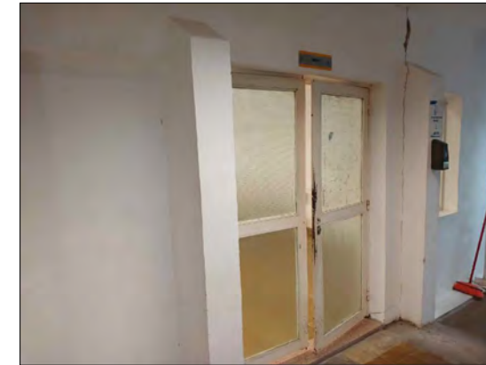
2)Pared Norte del Aula 2 - Rajadura vertical en mampostería de cierre. Además de presentarse un asentamiento en el solado interior.
