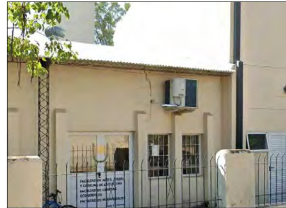
1)Pared Sur del Aula 2 - Rajadura vertical en mampostería de cierre sobre fachada. Se verifico un leve desplome en uno de sus tramos.
