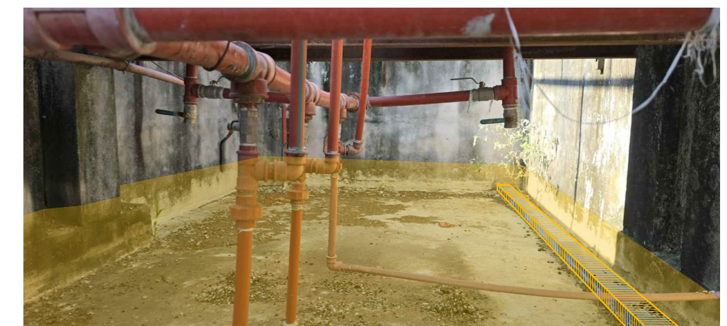
CARPETA DE PENDIENTE EXISTENTE A DEMOLER - CAÑO PLUVIAL TRAMO HORIZONTAL A DESMONTAR
