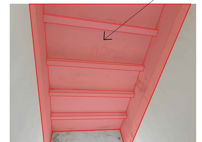
SUPERFICIE BAJO LOSA A TRATAR
