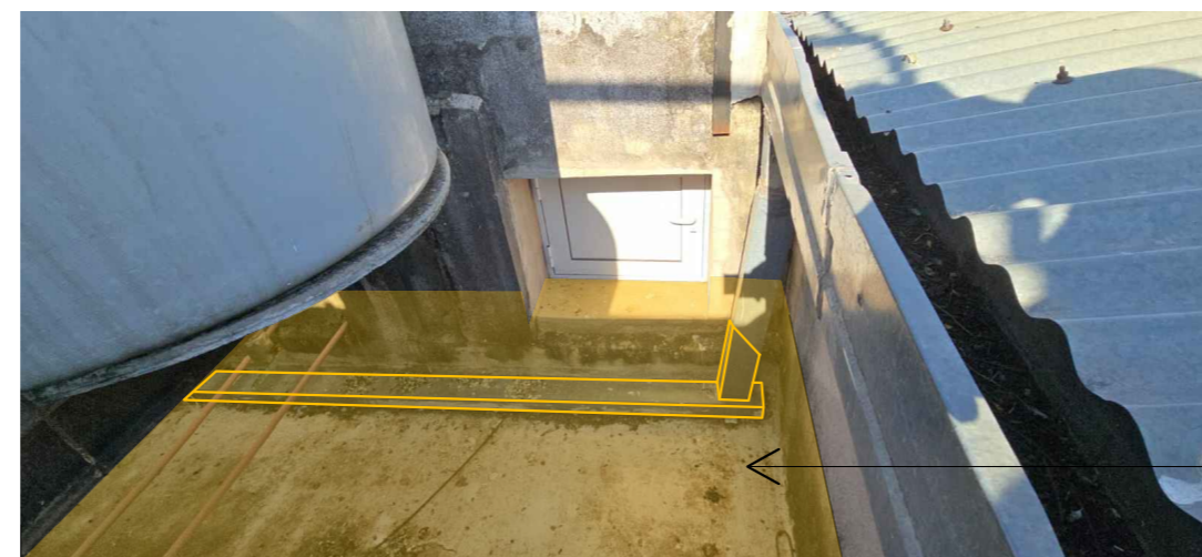
CARPETA DE PENDIENTE EXISTENTE A DEMOLER - CAÑO PLUVIAL TRAMO HORIZONTAL A DESMONTAR
