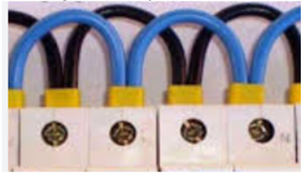
Conexión tipo guirnalda prohibida.
