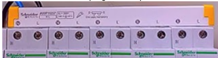
Conexión con peine de conexión.
