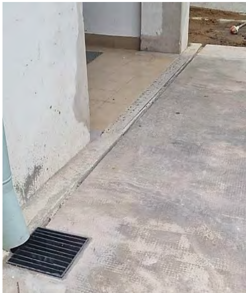
IZQUIERDA: estado actual del umbral con junta. DERECHA: rejilla a instalar.
