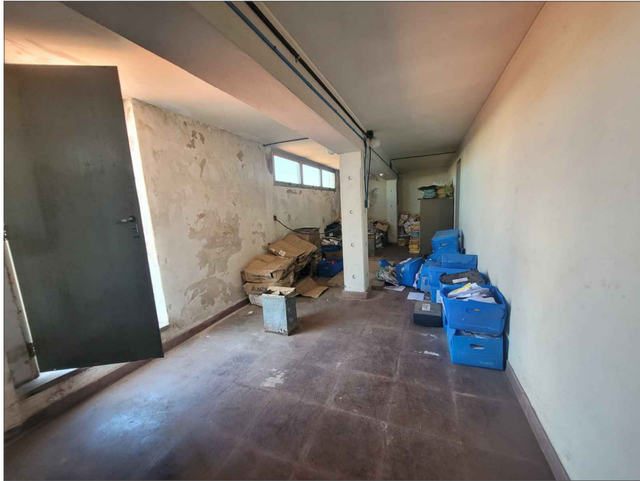
FOTO DE RELEVAMIENTO INTERIOR- PISO A PULIR-REVOQUE A DEMOLER
